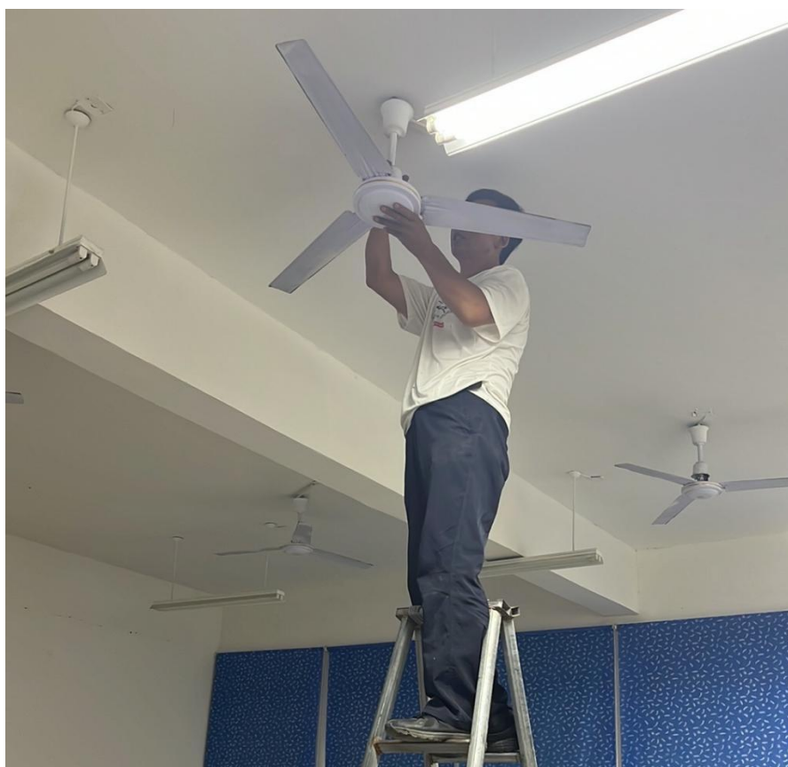
图 9：维修师傅检修教室风扇
